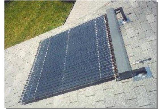
**Colector de tubos de vácuo**
