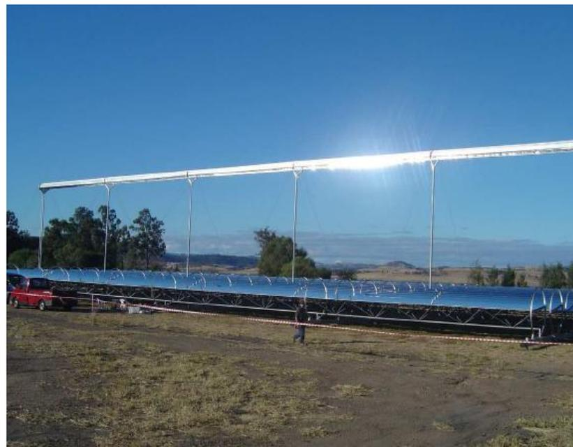
**Centrais do tipo Compact Linear Fresnel Reflector 6 MW**
